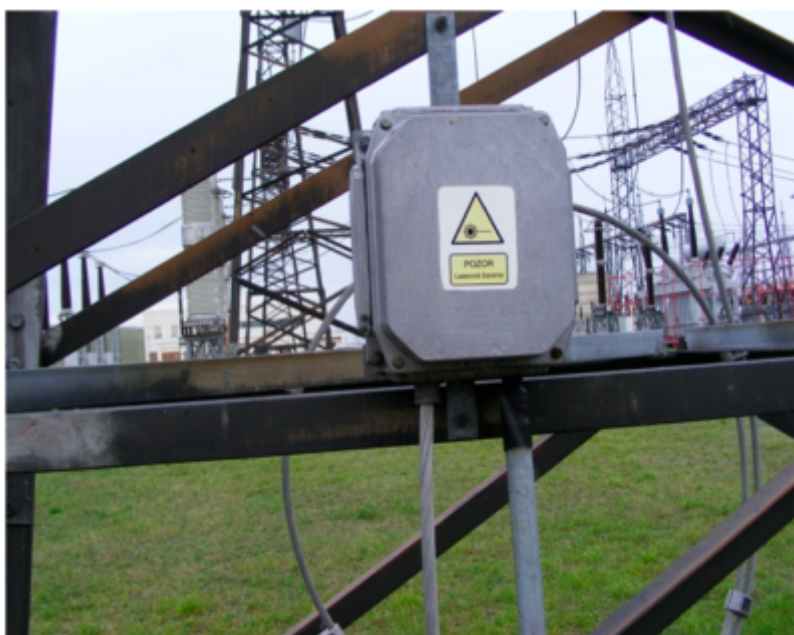
Obr. 2 Ukončenie zemného kombinovaného lana
