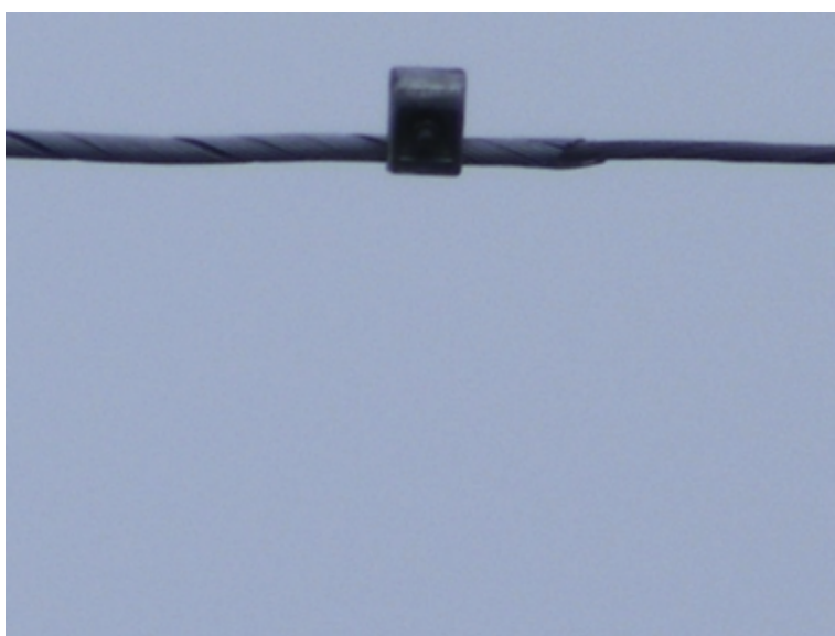
Obr.6 Ovinutie poškodeného úseku kombinovaného zemného lana a prichytenie opravnej špirály
