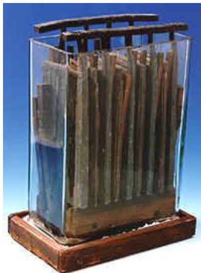
Obr. 3 Planté-ho olovený akumulátor [2]
