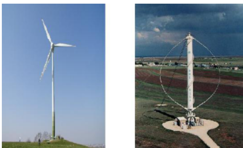
Obr. 3 Turbíny s horizontálnou osou a turbína s vertikálnou osou [5], [8]
